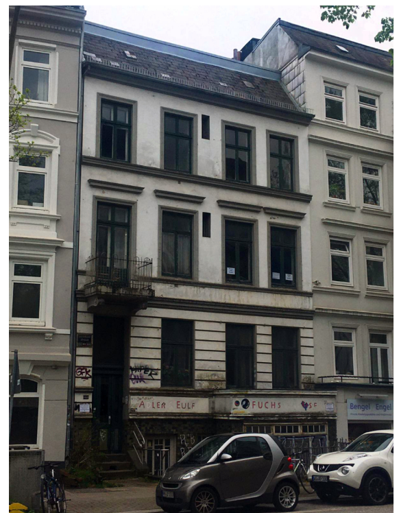
Methfesselstraße 80 droht der Abriss
